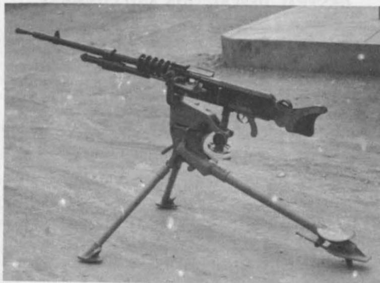
FRENCH 8-MM HOTCHKISS HEAVY MACHINE GUN, M14.
