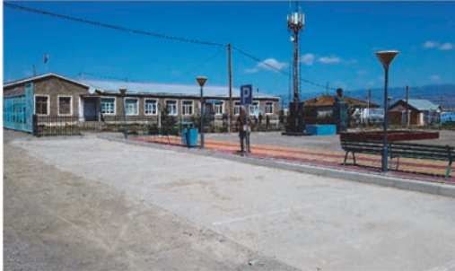
Abb. 33: Im Dachkasten dieses Gebäudes in Haliun im Gobi-Altai befindet sich wahrscheinlich ein Wochenstubenquartier von Plecotus strelkovi (Foto: L. LEISERING).
